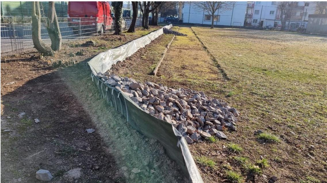
Abb. 9 & 10: Beispielbilder für die Umsetzung und Anlage eines Reptilien- und Amphibienzauns mit eingriffsseitiger Kletterhilfe. Fotos: Mark Baubkus.
